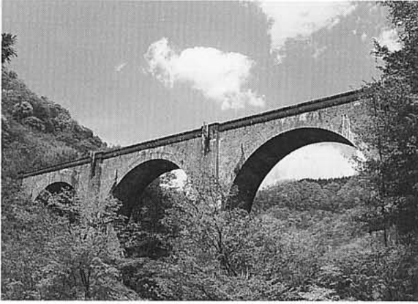
めがね橋（碓氷第三橋梁）
